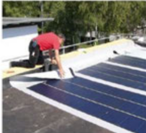
Membrane souple – Toit Terrasse
